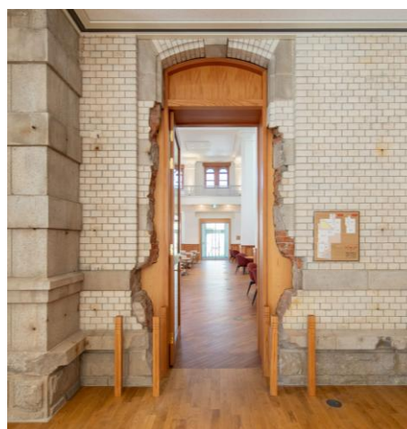
旧銀行棟の外壁とレンガ躯体
